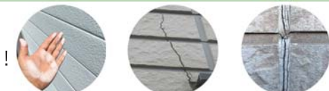
□塗膜劣化 □外壁クラック □シーリング劣化
